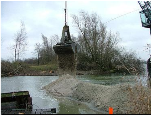
Figuur 2: Aanbouw van dammen bij “Het Groene Eiland”
